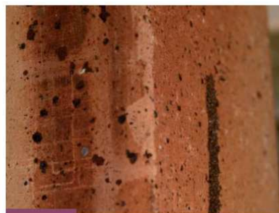
Construction d'une galerie tunnel (cordonnnet) sur brique
