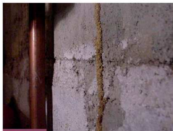
Construction d'une galerie tunnel (cordonnnet) sur maçonnerie
